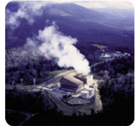
澄川地熱発電所
