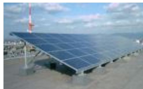
福岡市本庁舎屋上
