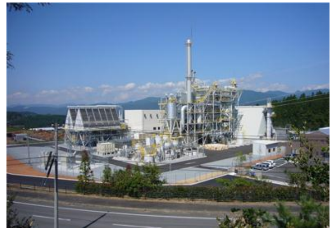
日田ウッドパワー日田発電所
