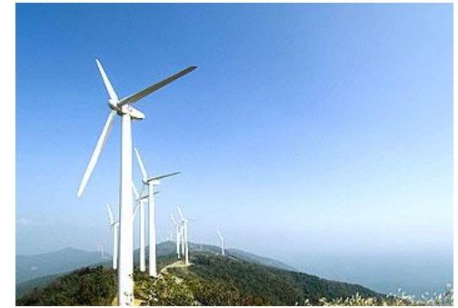
佐多岬風力発電所
