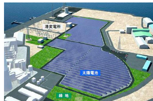
メガソーラー大牟田発電所
